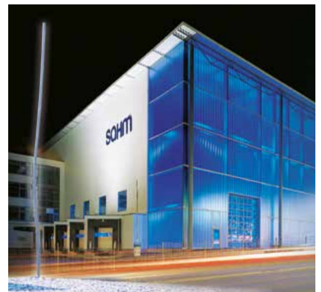
Das SAHM Hochregallager mit Glasfassade an unserer deutschen Firmenzentrale in Höhr-Grenzhausen, Westerwald.
